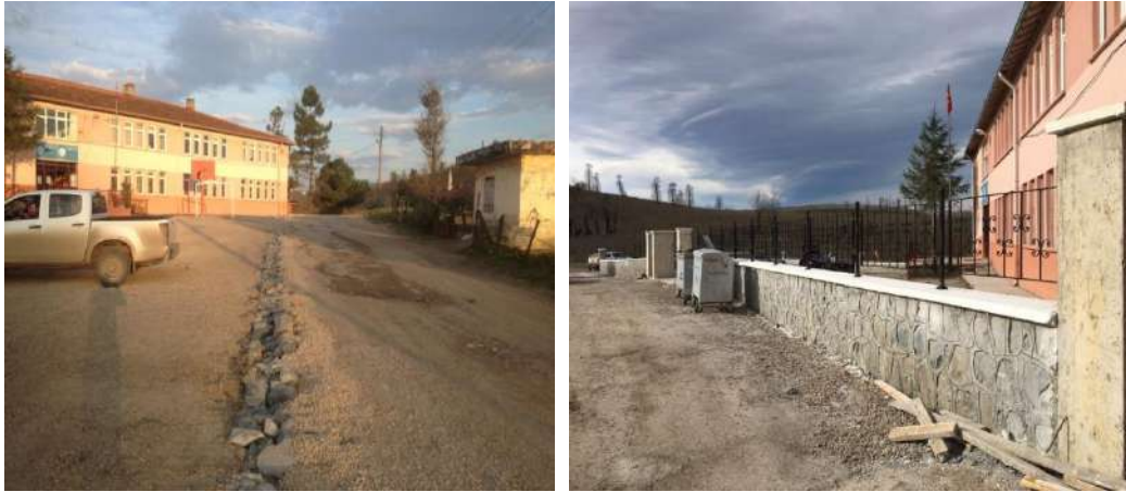
Bayadı Mahallesi İlköğretim Okulu İhata Duvarı Yapım İşİ ( Devam Ediyor. )
