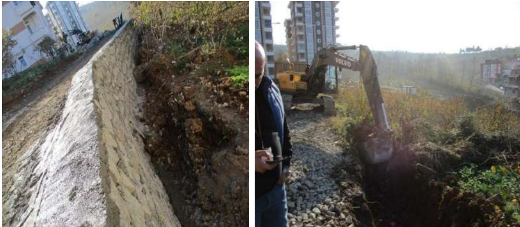
Bucak Mahallesi 437. Sokak Moloztaş Duvar Yapım İşİ İlk/Son Hali
