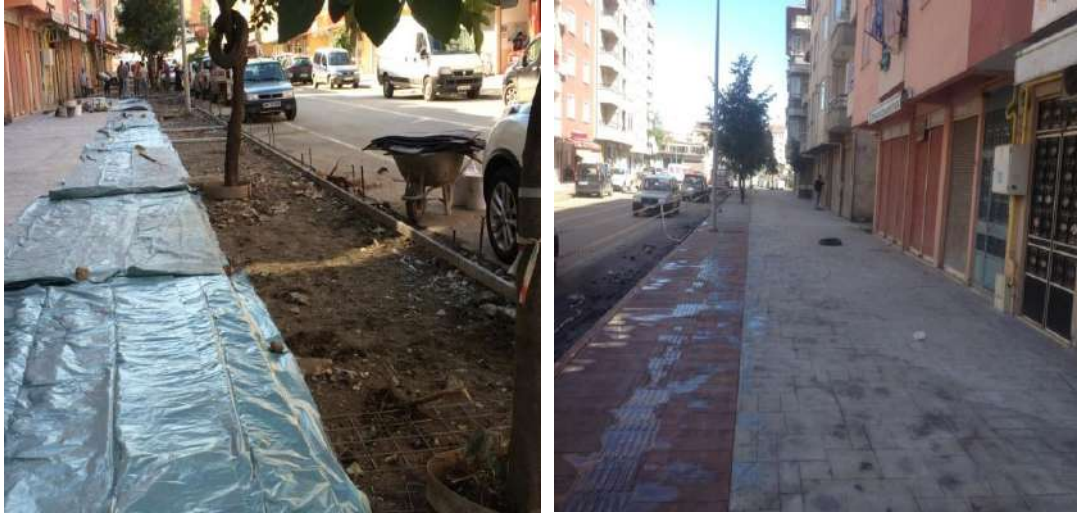
Yeni Mahalle 323. Sokak Baskı Beton Çalışmaları İlk/Son Hali
