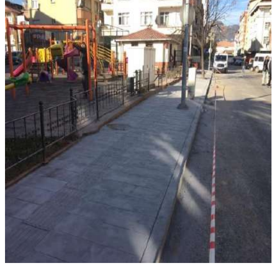
Subaşı Mahallesi 472. Sokak Baskı Beton Çalışmaları İlk/Son Hali
