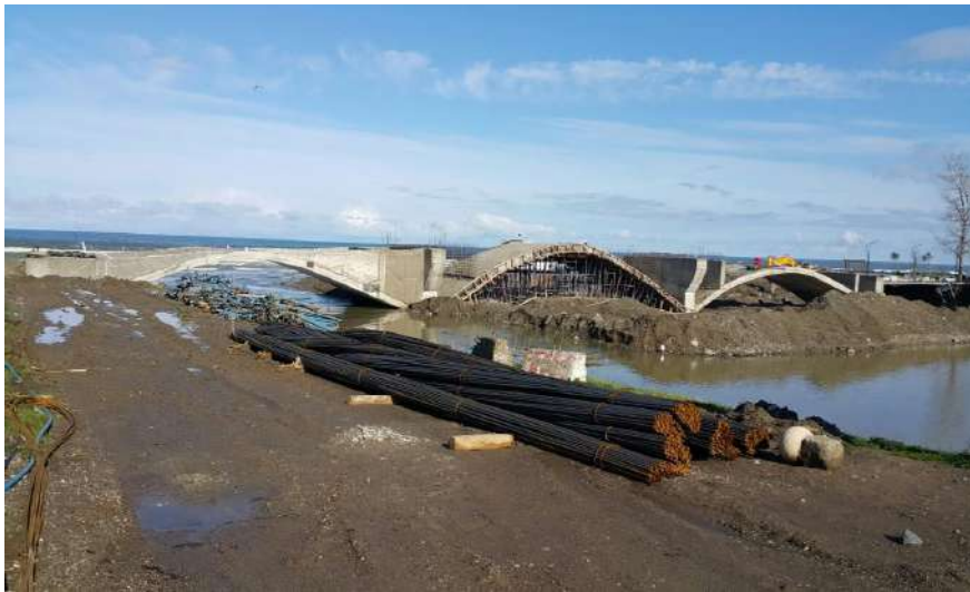
Mostar Köprü Projesi Yapım İşi Son Durum
