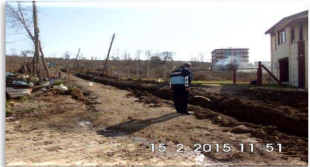
Doğalgaz Çalışmasında Sokağın Trafığa Kapatılması
