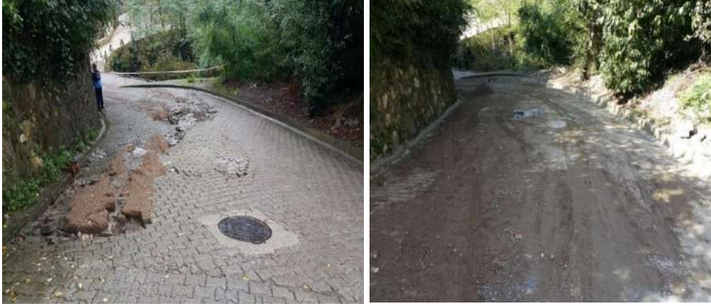
Kirazlımanı Mahallesi 110. Sokak Parke Bakım-Onarım Çalışması İlk/Son Hali
