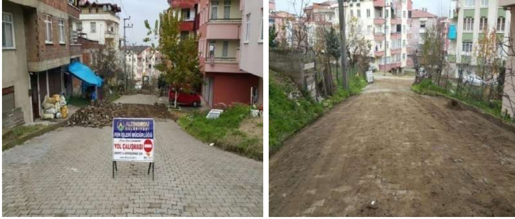
Şirinevler Mahallesi 709. Sokak Parke Bakım-Onarım Çalışması İlk/Son Hali
