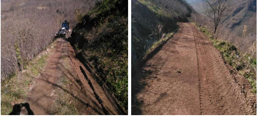
Gümüşköy Mahallesi Yol Genişletme Bakım-Onarım Çalışması İlk/Son Hali
