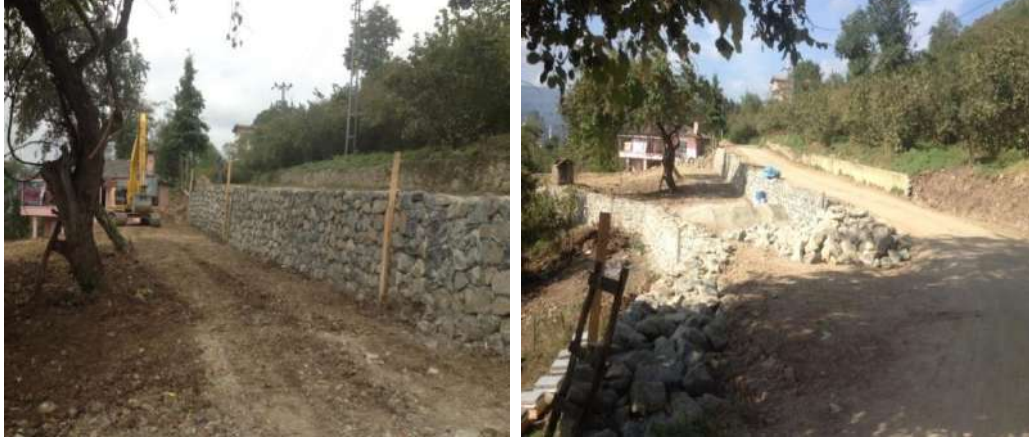
Akkese Mahallesi Moloztaş İksa Duvarı Yapım İşİ
