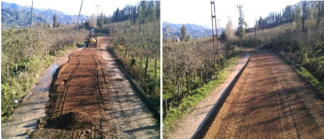
Karapınar Mahallesi Yol Genişletme Bakım-Onarım Çalışması
