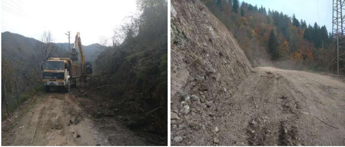
Hürriyet Mahallesi Yol Genişletme ve Bakım- Onarım Çalışması
