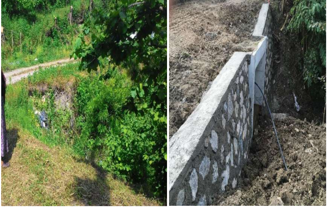
Eyüplü Mahallesi Kurdan Sokak Kutu Menfez Yapım İşİ İlk / Son Hali
