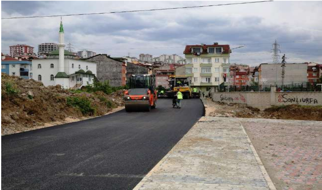
Şirinevler Mahallesi Asfaltlama İşİ İlk/Son Hali
