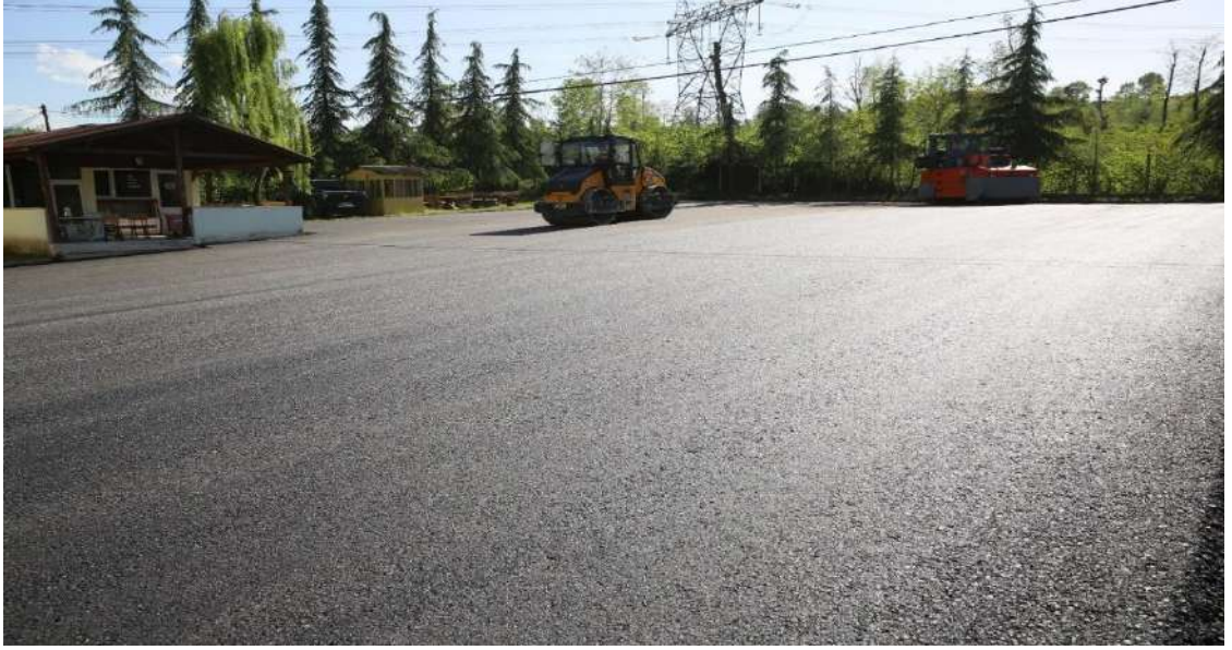
Kökenli Mahallesi Kamyon Garajı Asfaltlama Yapım İşi
