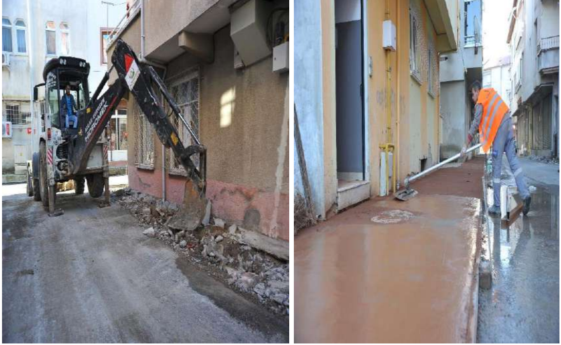
Karşıyaka Mahallesi Baskı Beton Çalışması İlk/Son Hali Karşıyaka Mahallesi 12016,52 m 2 baskı beton kaldırım yapılmıştır.
