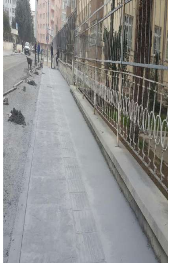
Bahçelievler Mahallesi Edibe Akyol Caddesi Baskı Beton Çalışması İlk/Son Hali
