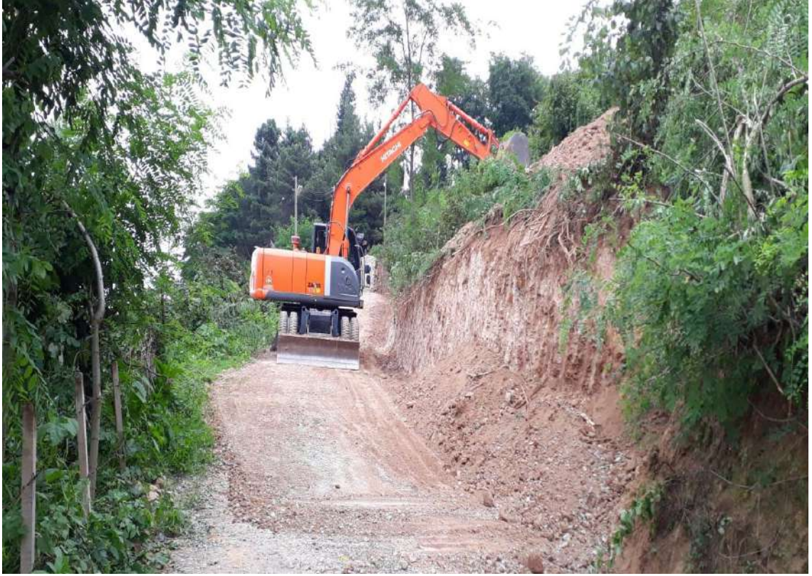
Kayabaşı Mahallesi Yol Geniřletme alıřması
