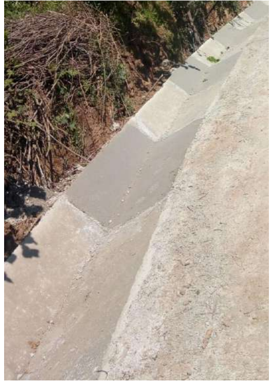
Akçatepe Mahallesi Dervişli Sokak Beton Yol- V Kanal Çalışması İlk/Son Hali
