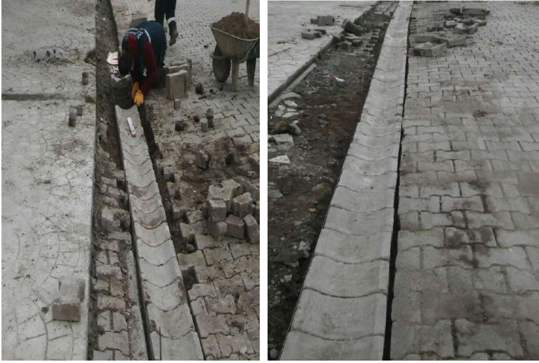
Karşıyaka Mahallesi 903.Sokak Parke ,Oluk, Bordür Bakım-Onarım Çalışması İlk/Son Hali
