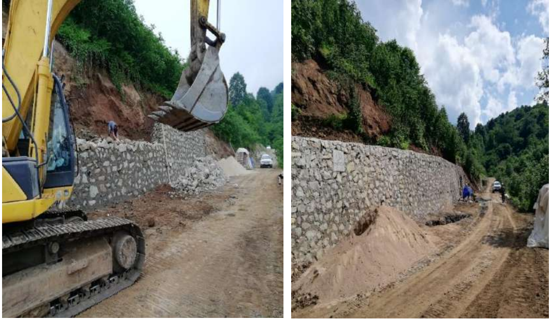
Bahariye Mahallesi Çırakıran Sokak Moloztaş İksa Duvarı Yapım İşi İlk / Son Hali
