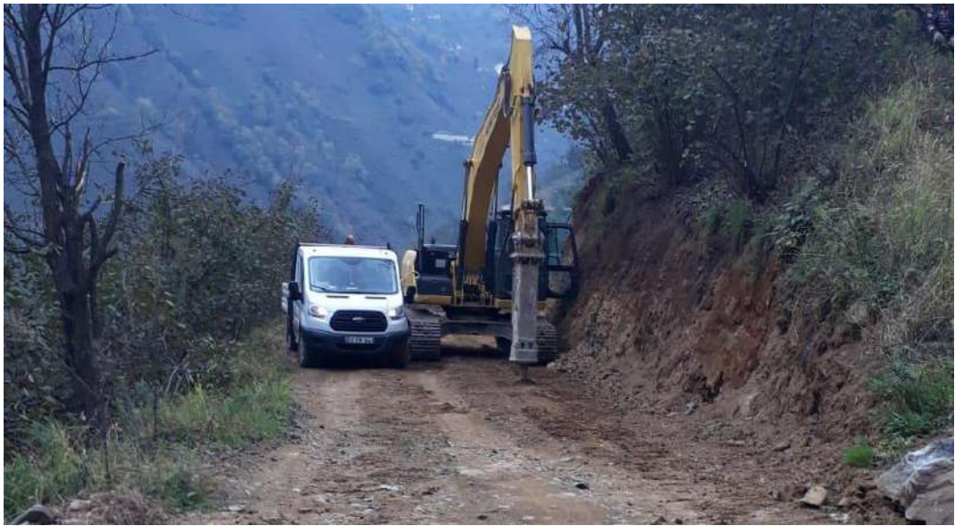
Alınca Mahallesi Yol Genişletme Çalışması
