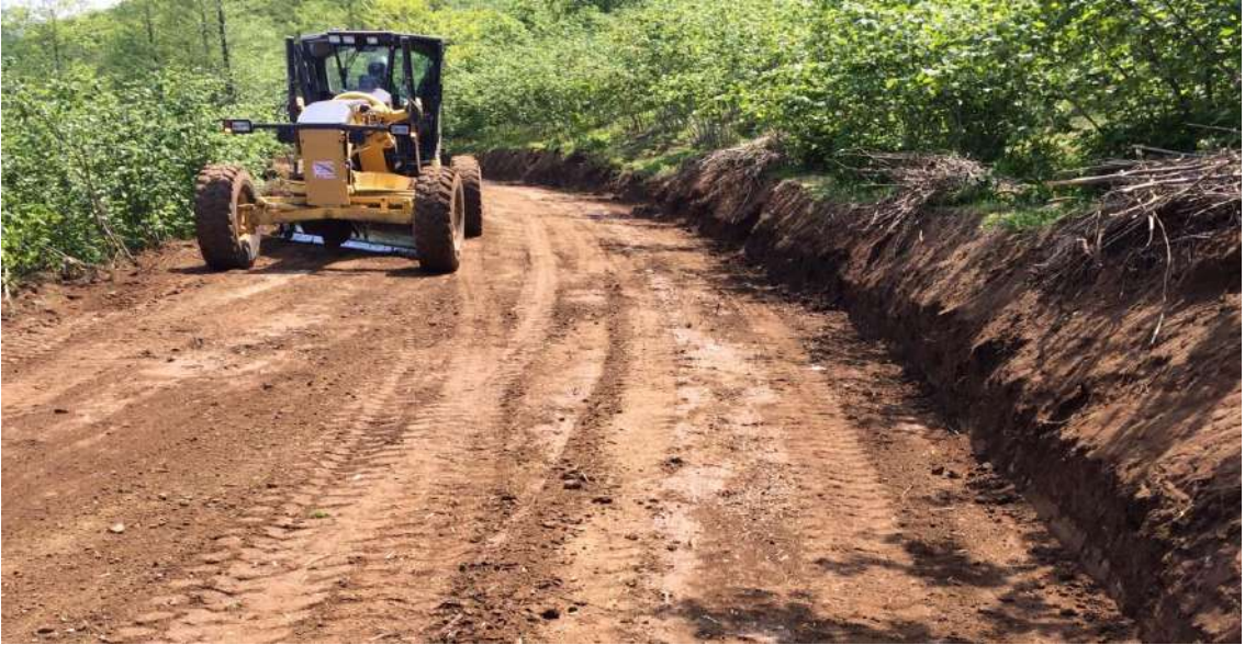
Karaoluk Mahallesi Yol Bakım-Onarım Çalışması
