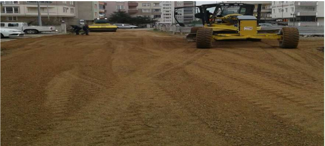
Karşıyaka Mahallesi Yol Bakım-Onarım Çalışması
