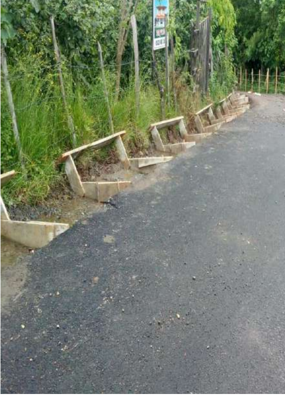
Çavuşlar Mahallesi - Burhanettin Mahallesi Sarıkış Sokak Bağlantı Yolu Beton Yol- V Kanal Çalışması İlk/Son Hali
