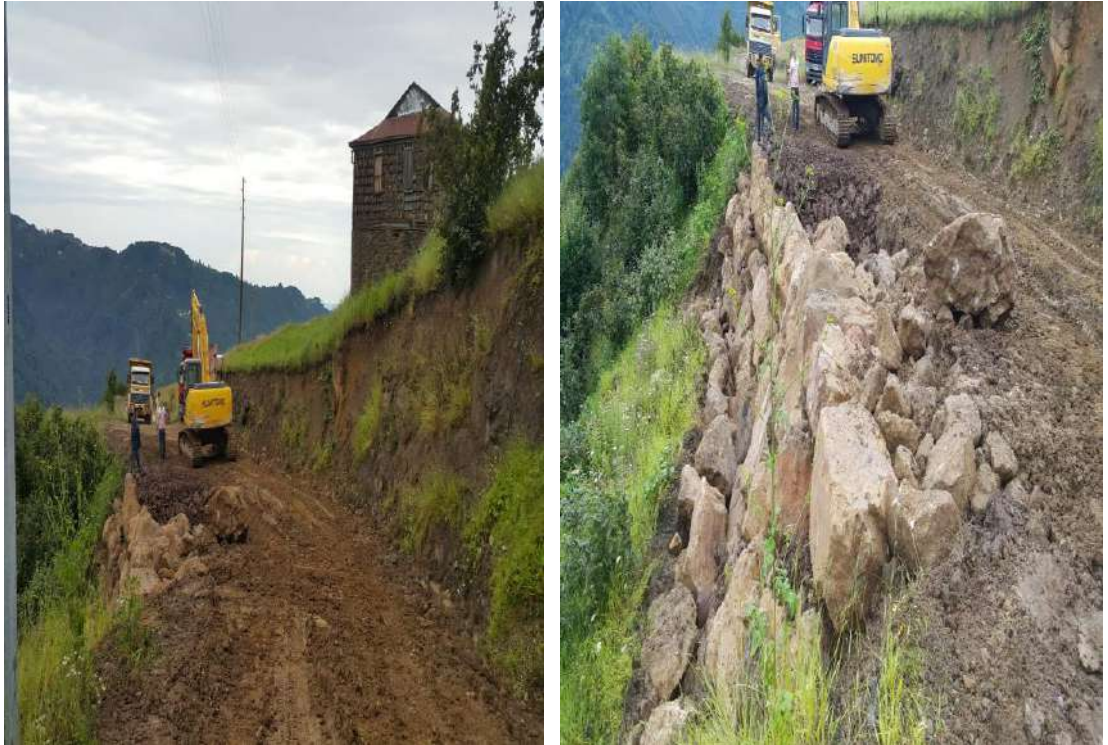
Aydınlık Mahallesi Keldağ Sokak Taş Tahkimat Yapım İşi İlk / Son Hali
