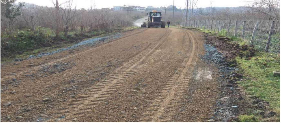
Uzunisa Mahallesi Yol Bakım-Onarım Çalışması
