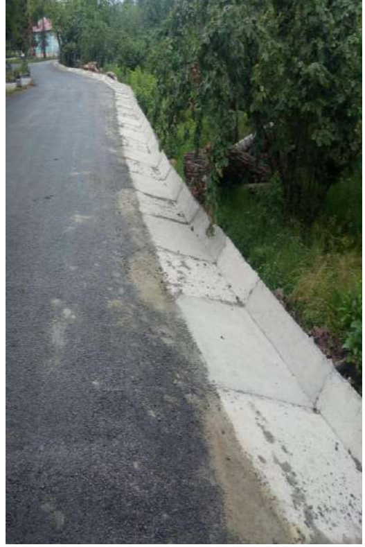
Çavuşlar Mahallesi - Burhanettin Mahallesi Sarıkış Sokak Bağlantı Yolu Beton Yol- V Kanal Çalışması İlk/Son Hali
