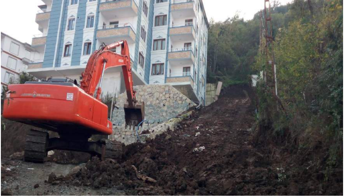
Kumbaşı Mahallesi 72 Nolu Sokak imar yolu çalışması
