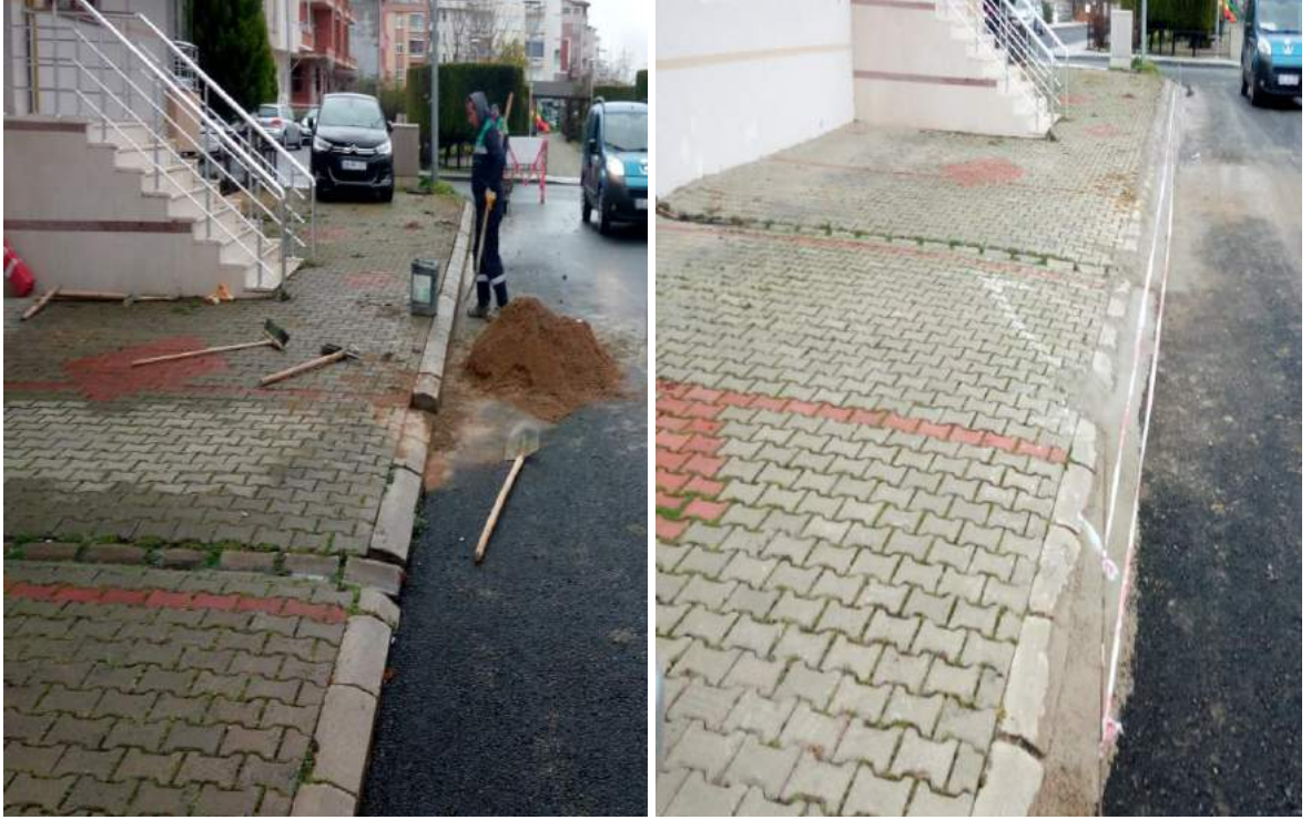
Akyazı Mahallesi 795 Nolu Sokak bordür bakım-onarım çalışması ilk/son hali
