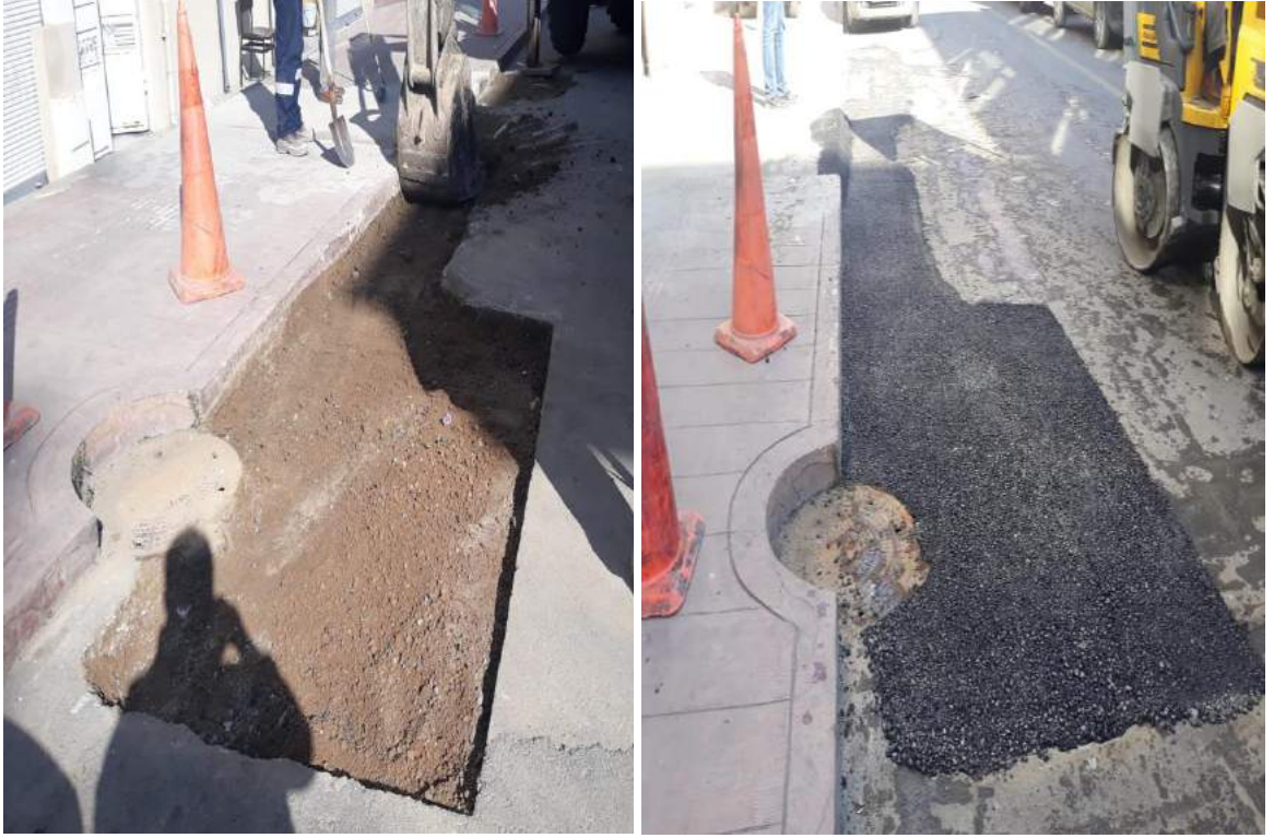
Subaşı Mahallesi 471 Nolu Sokak asfalt yama çalışması ilk/son hali
