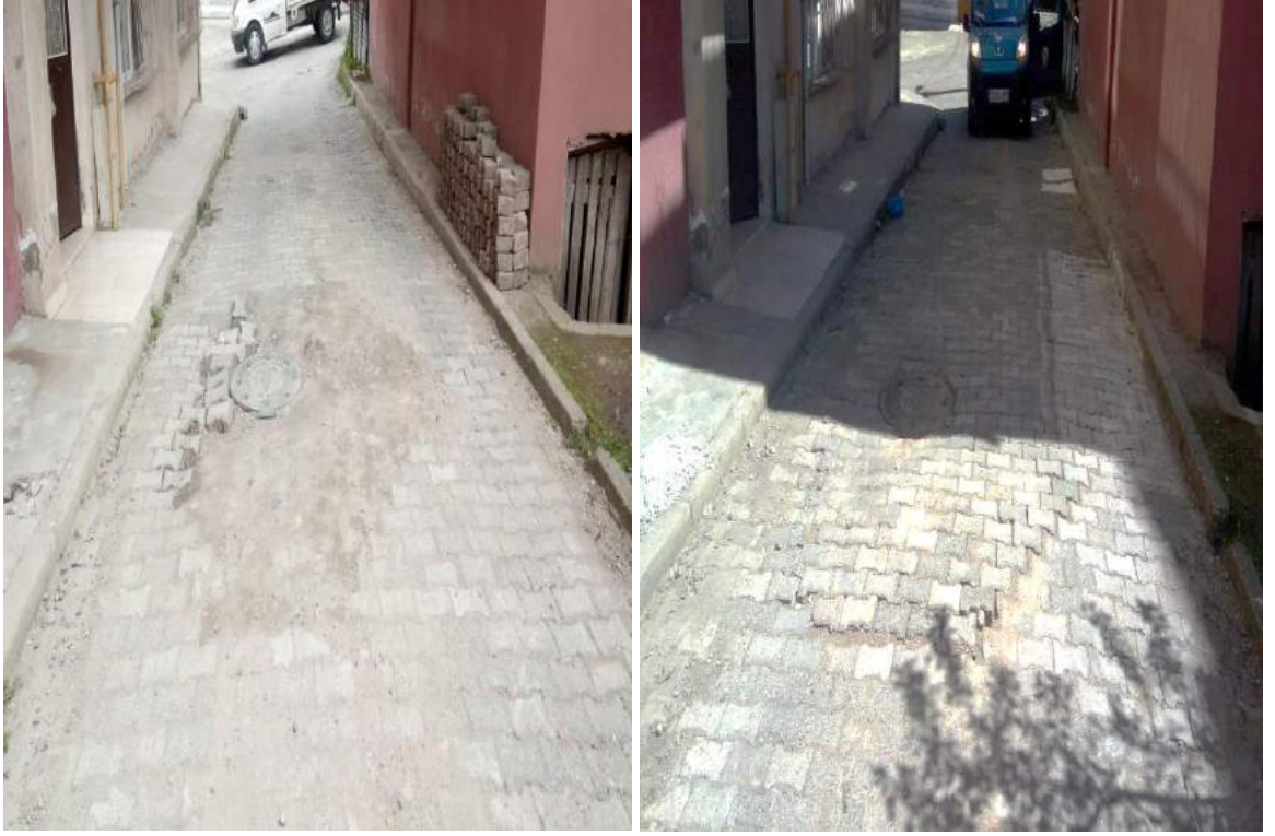
Şirinevler Mahallesi 708 Nolu Sokak parke bakım-onarım çalışması ilk/son hali
