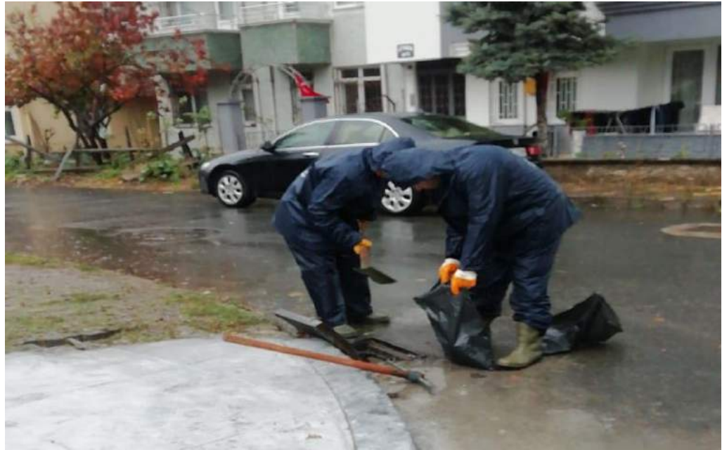
Personel ile yapılan mazgal açma işlemi
