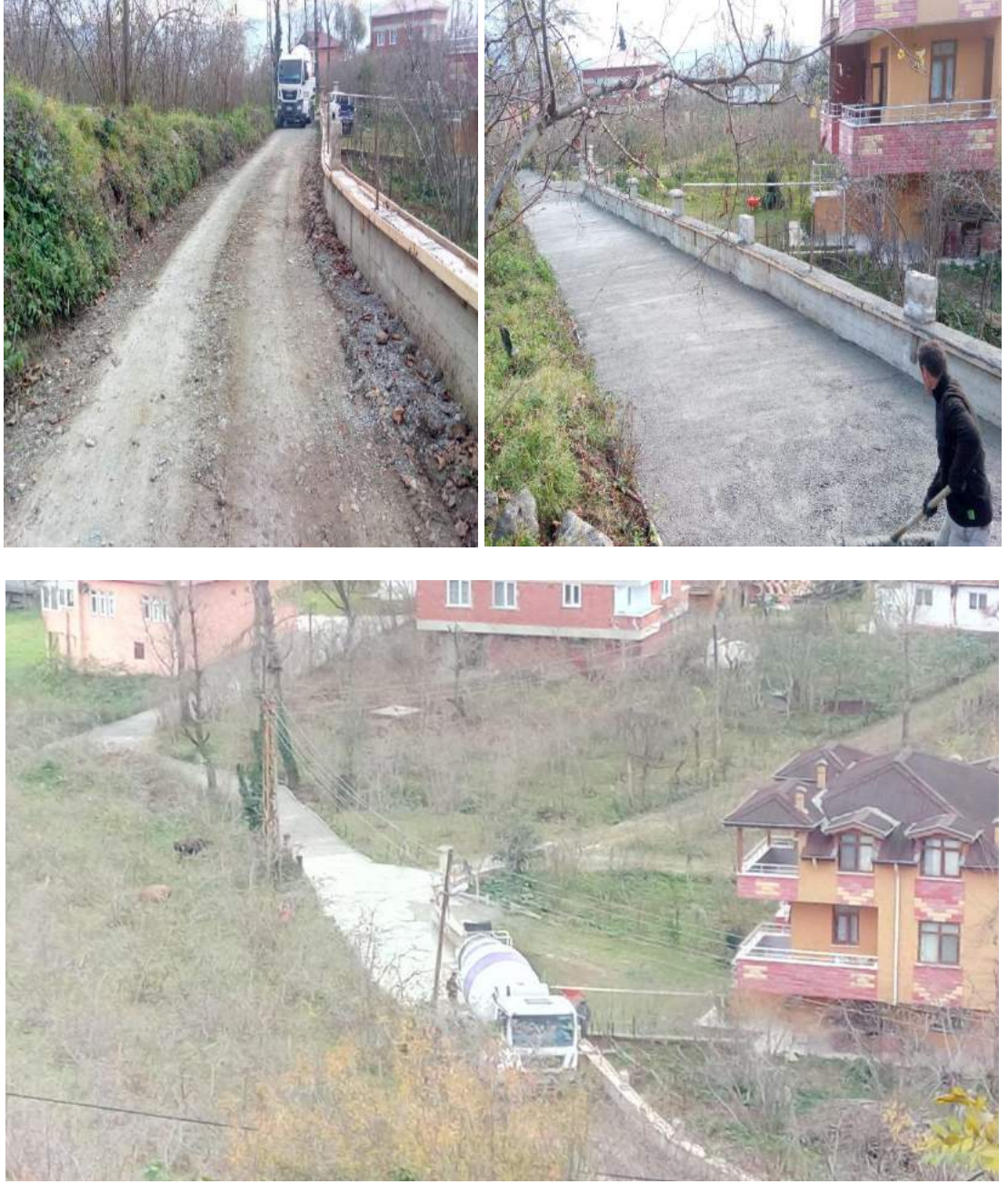
Çavuşlar Mahallesi Kırınbaşı Sokak-3 beton yol yapım işi ilk / son hali
