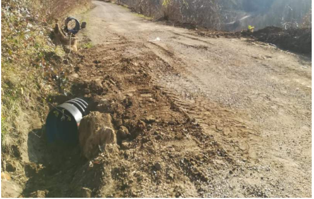
Günören Mahallesi Makaroğlu Sokak koruge boru imalatı
