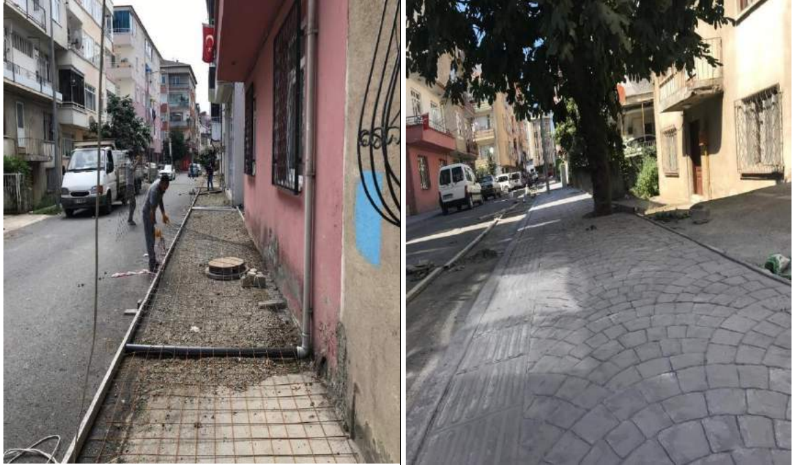
Bucak Mahallesi 358 Nolu Sokak baskı beton çalışması ilk/son hali
