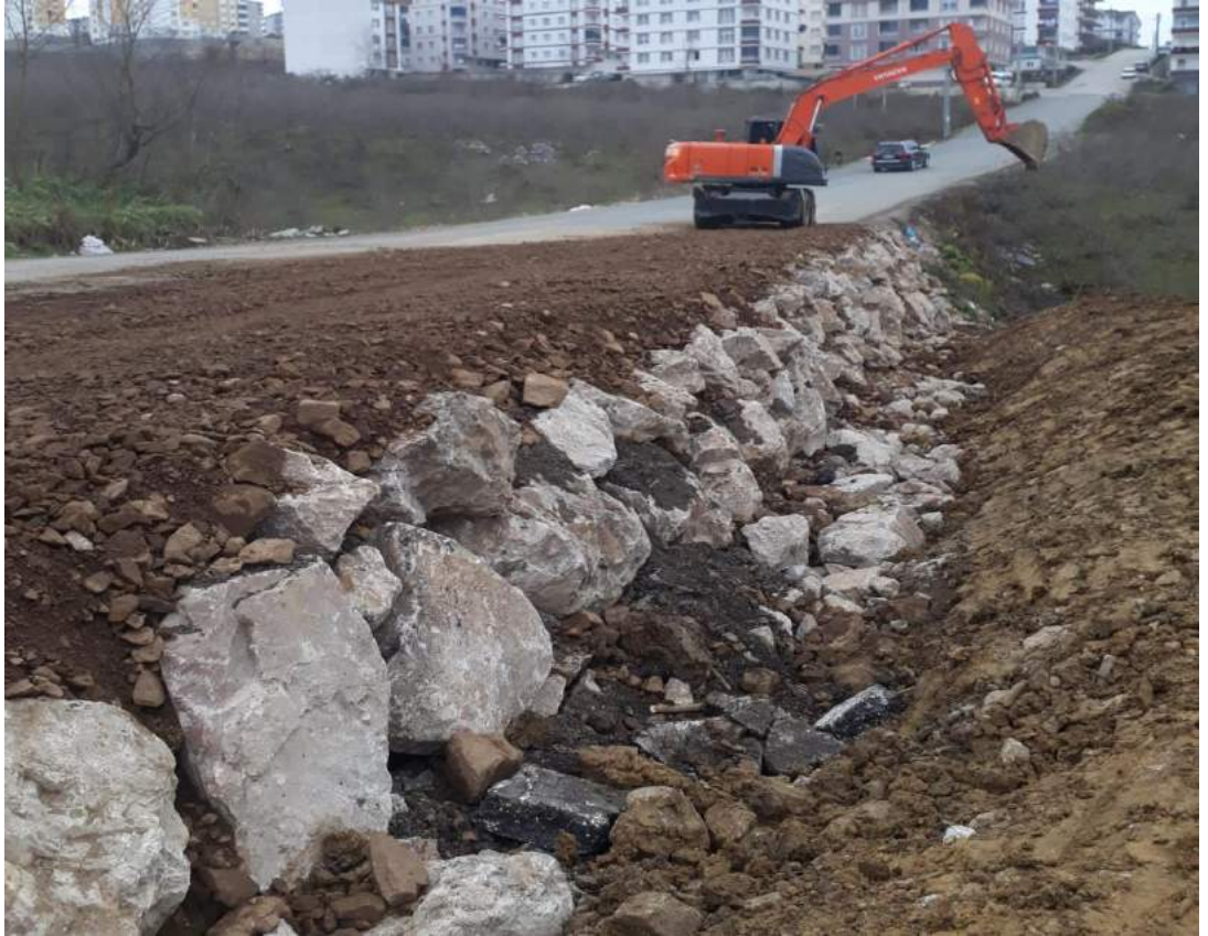
Şahincili Mahallesi 649 Nolu Sokak taş tahkimat yapım işi
