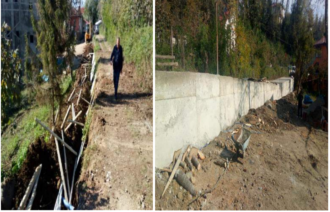
Çavuşlar Mahallesi Kıranbaşı Sokak-3 betonarme duvar yapım işi ilk / son hali
