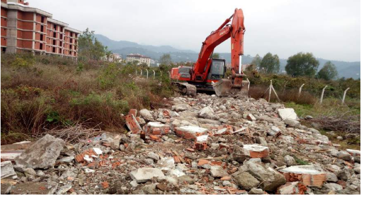
Cumhuriyet Mahallesi 1380 Nolu Sokak imar yolu çalışması
