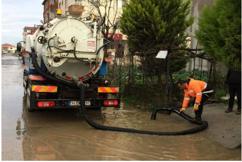
Personel ile yapılan mazgal açma işlemi
