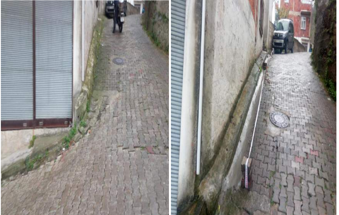
Zaferimilli Mahallesi 160 Nolu Sokak beton oluk yapım işi ilk/son hali
