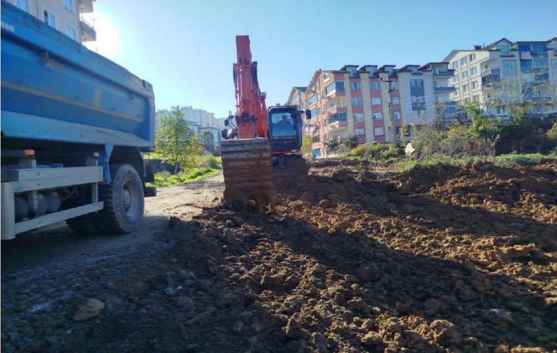
Şahincili Mahallesi 571 Nolu Sokak İmar Yolu Çalışması
