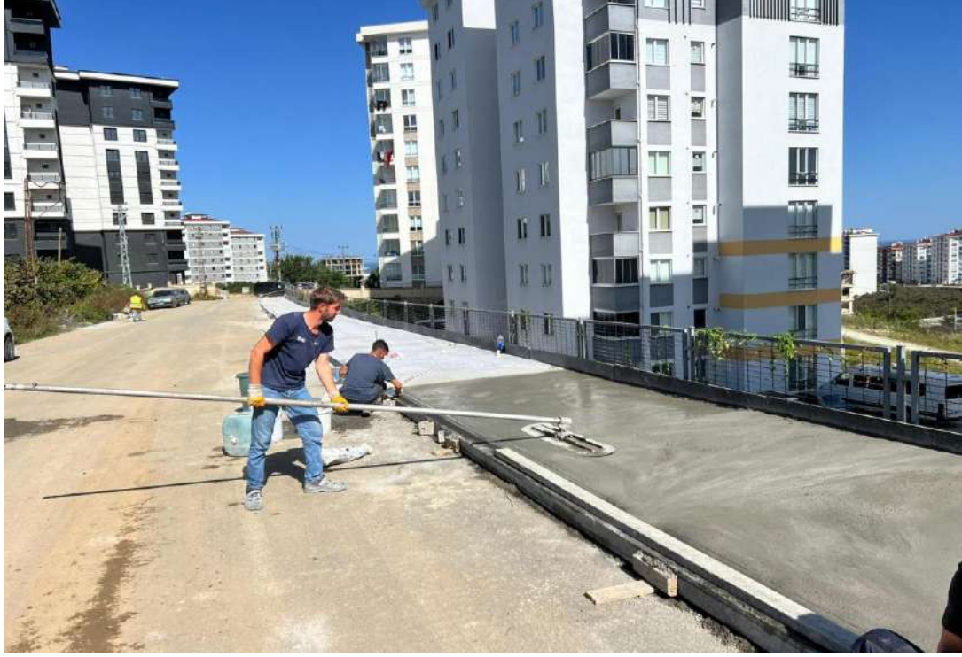
Karşıyaka Mahallesi 1043 Nolu Sokak Baskı Beton Kaldırım Yapım İşi
