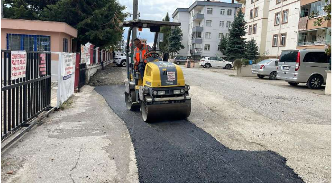
Cumhuriyet Mahallesi 1415 Nolu Sokak Asfalt Yama Çalışması
