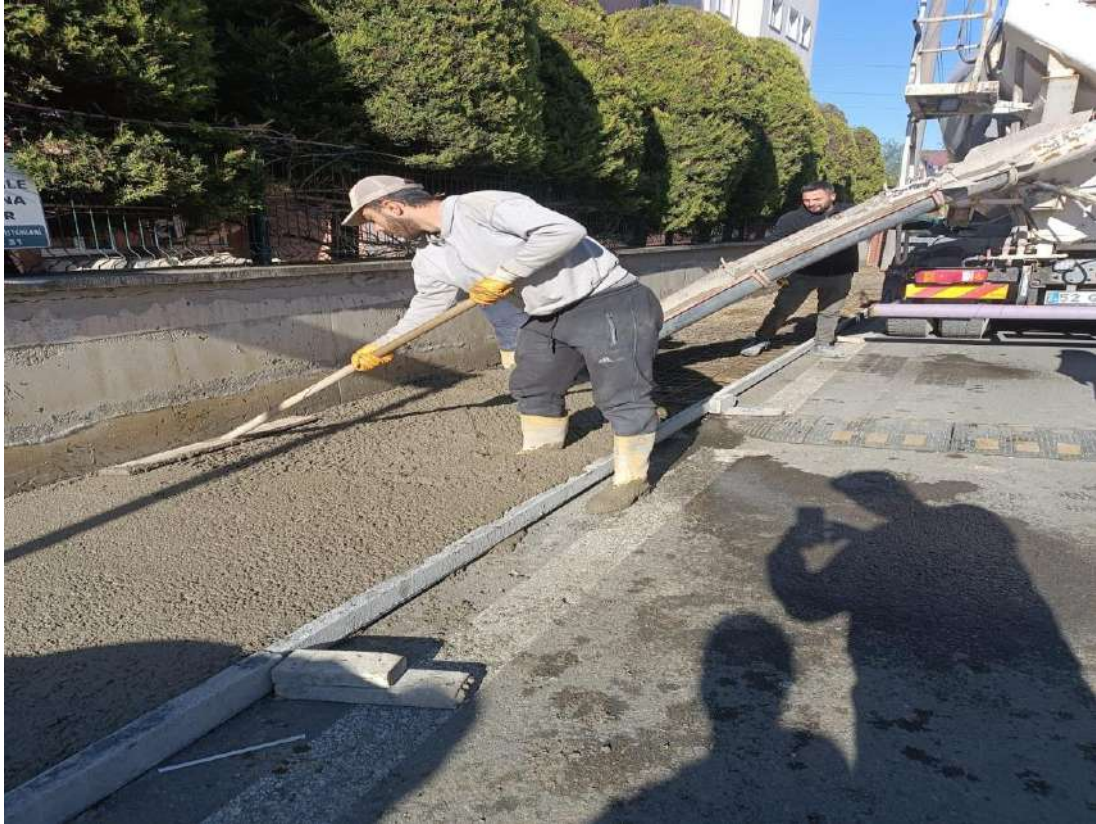
Şahincili Mahallesi 609 Nolu Sokak Baskı Beton Kaldırım Yapım İşi
