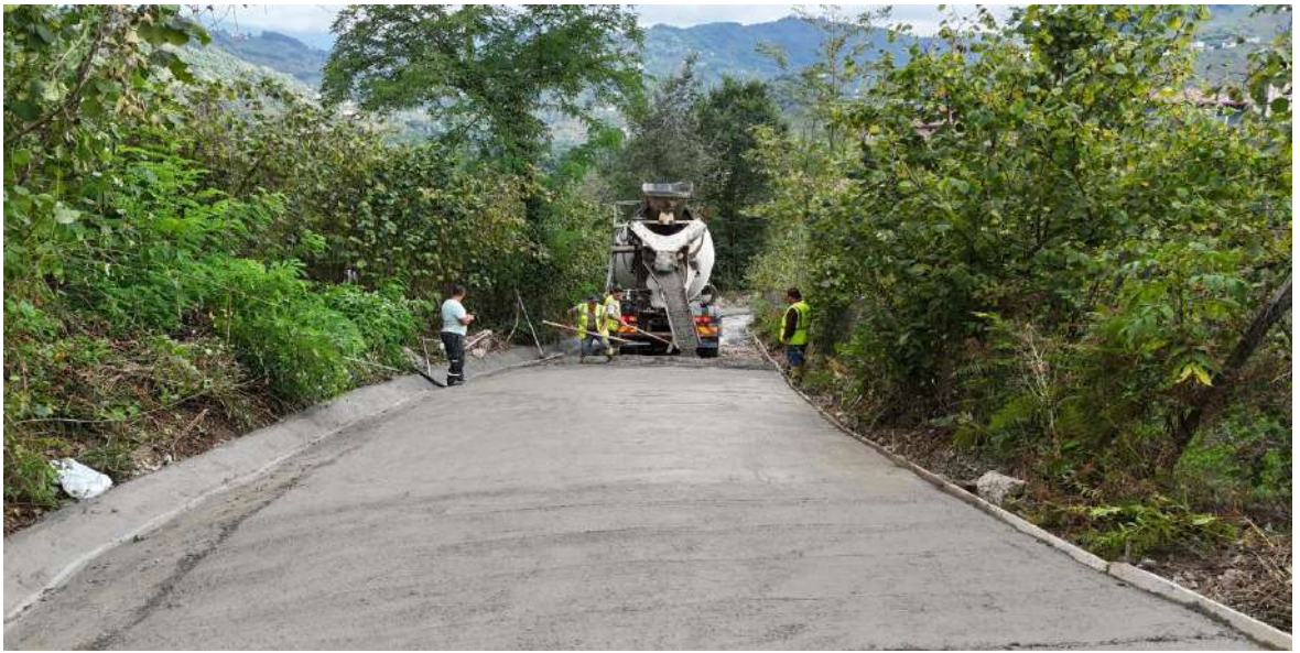
Karapınar Mahallesi Köyiçi Mevkii-2 Beton Yol Yapım İşi
