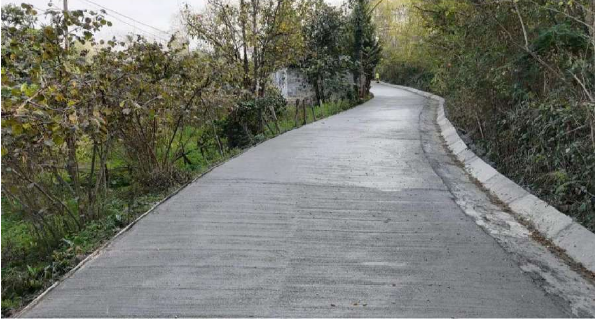
Yarışlı Mahallesi Çankaza Sokak V Kanal İmalatı
