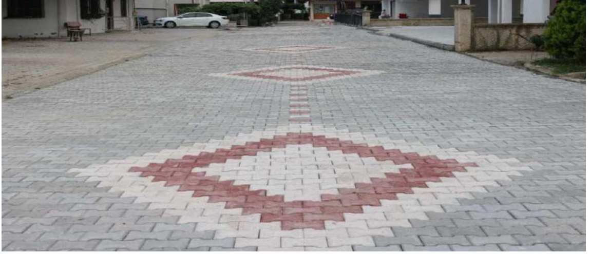
Kumbaşı Mahallesi 31 Nolu Sokak Parke Bakım-Onarım Çalışması
