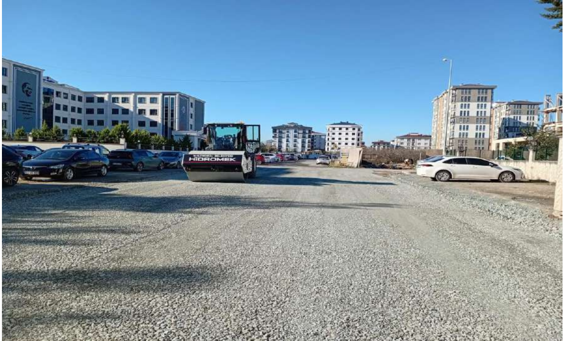
Cumhuriyet Mahallesi 1423 Nolu Sokak Yol Bakım-Onarım alıřması
