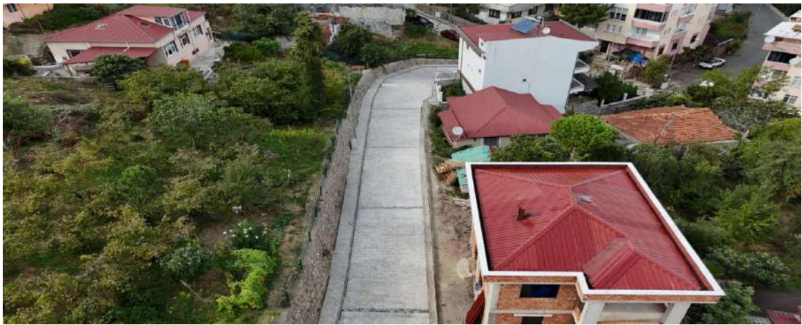
Kirazlımanı Mahallesi 113 Nolu Sokak Parke Yol Yapım İşi
