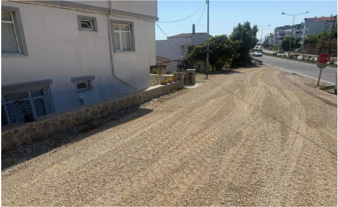
Güzelyalı Mahallesi Bozukkale Mevkii Yol Bakım-Onarım Çalışması
