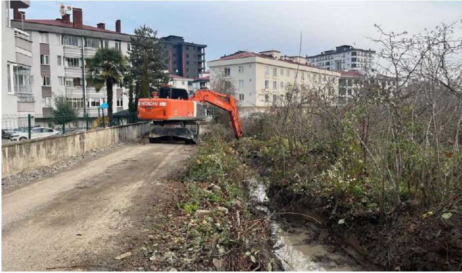
Cumhuriyet Mahallesi Kanal Temizleme Çalışması
