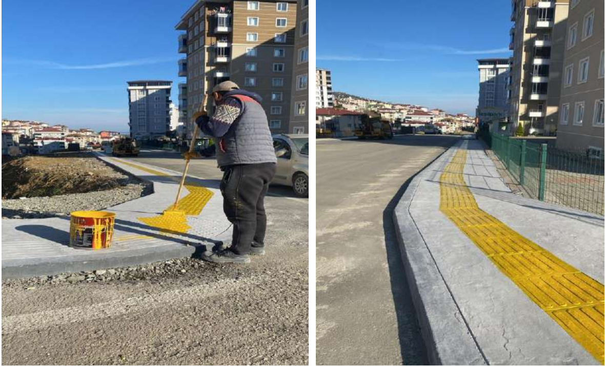
Bucak Mahallesi 454 Nolu Sokak Baskı Beton Çalışması
