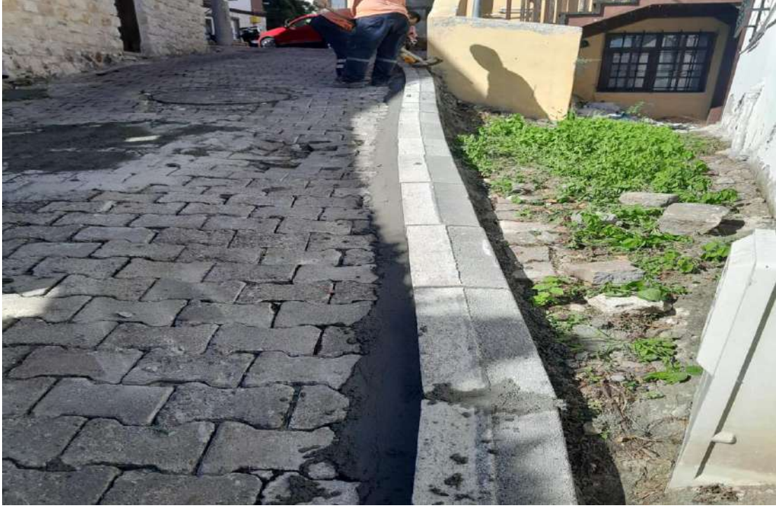
Zaferimilli Mahallesi Türk Sokak Beton Bordür Yapım İşi
