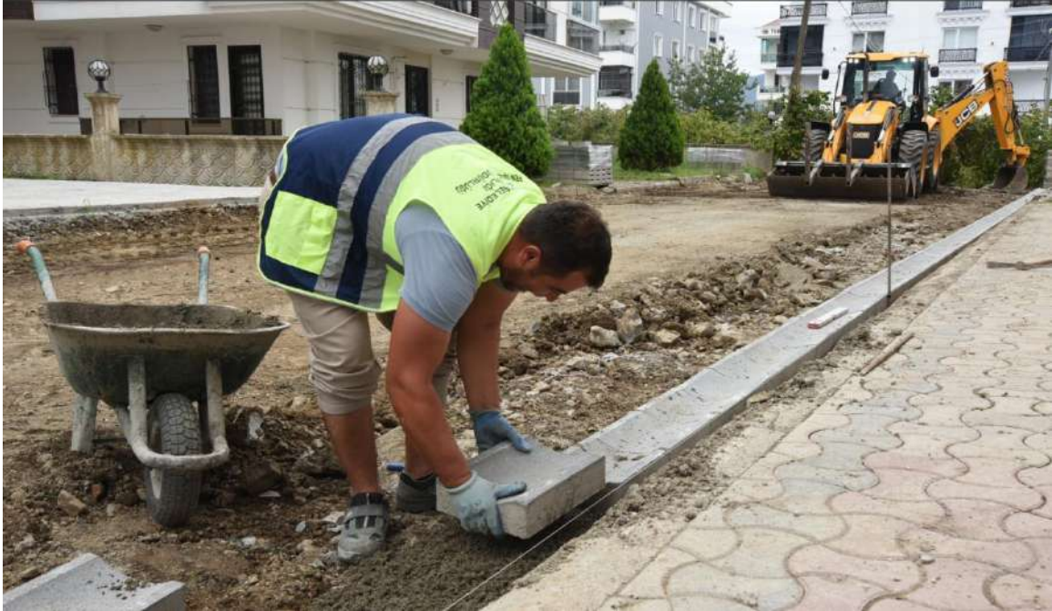
Kumbaşı Mahallesi 31 Nolu Sokak Oluk Yapım İşi
