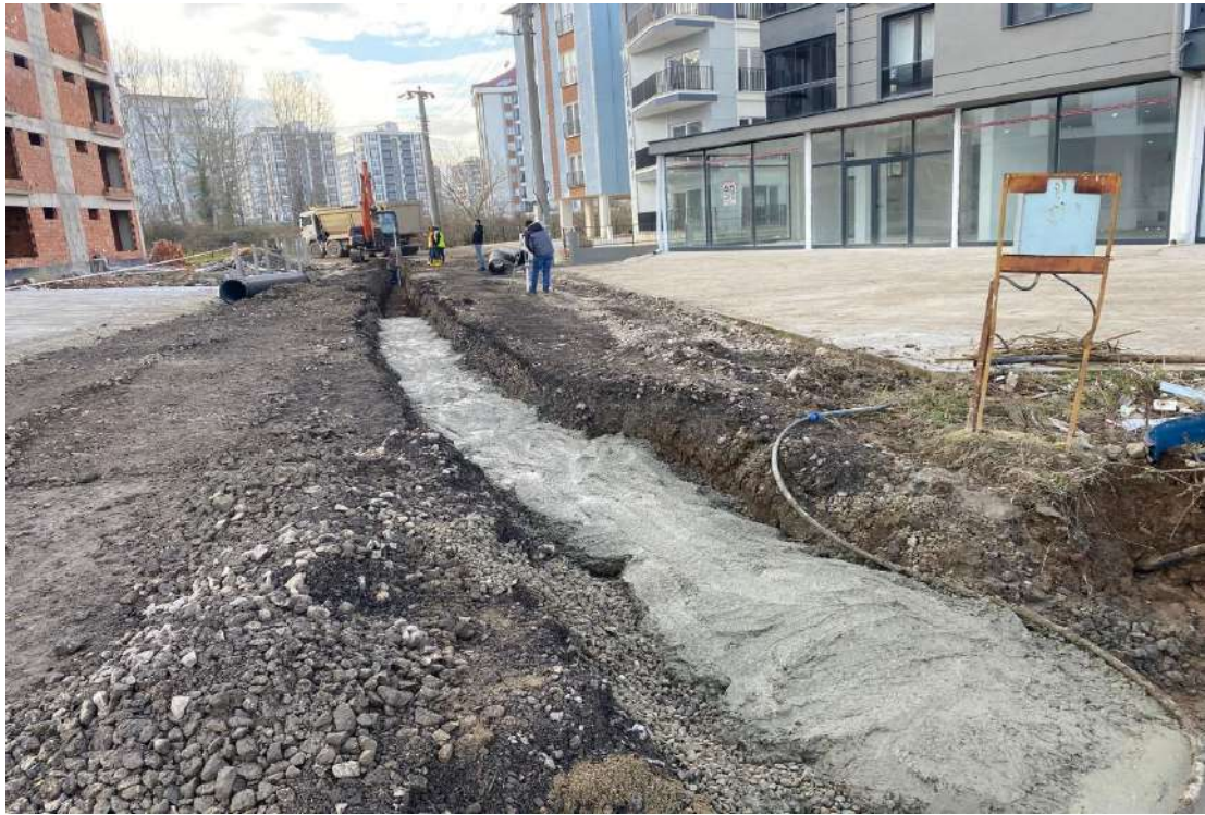
Cumhuriyet Mahallesi 1408 Nolu Sokak Yağmursuyu Hattı Yapım İşi
