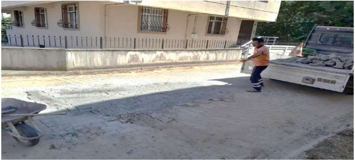
Karşıyaka Mahallesi 934 Nolu Sokak Parke Bakım-Onarım Çalışması
