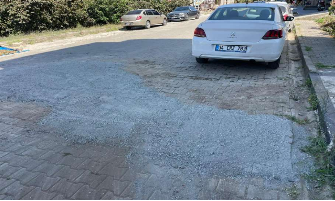
Kumbaşı Mahallesi 3 Nolu Sokak Parke Bakım-Onarım Çalışması
